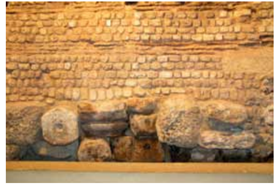
Assises des fondations du musée d'Evreux avec mise au jour des blocs de remplissage.
